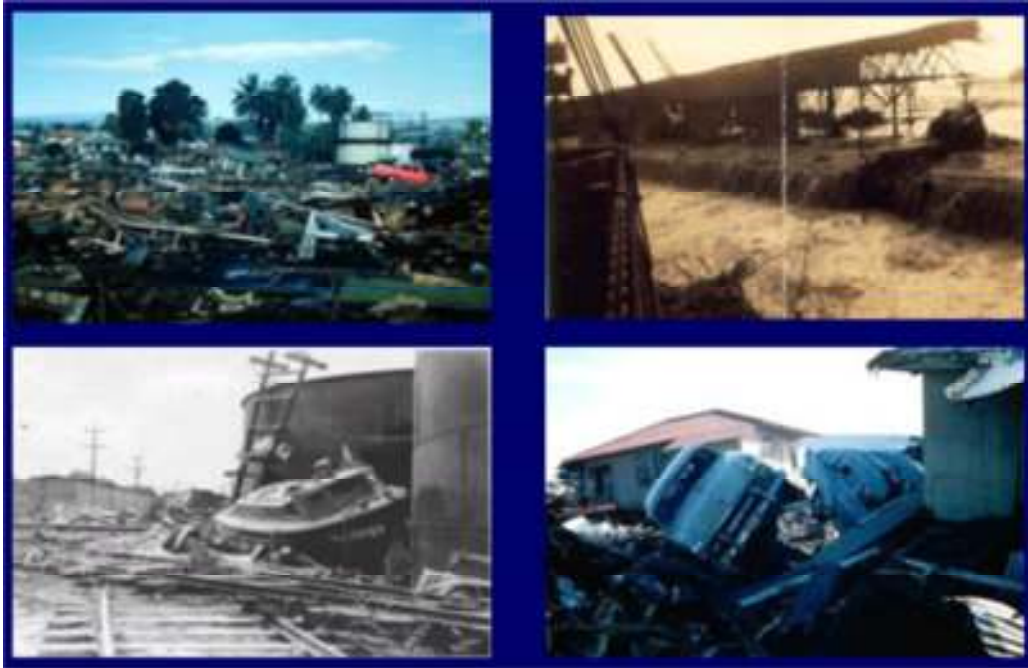
TSUNAMI 21-ABR-1946 HILO HAWAII TERREMOTO 7.3° EN ISLAS ALEUTIANAS GENERO OLAS MAYORES DE 10 m.
