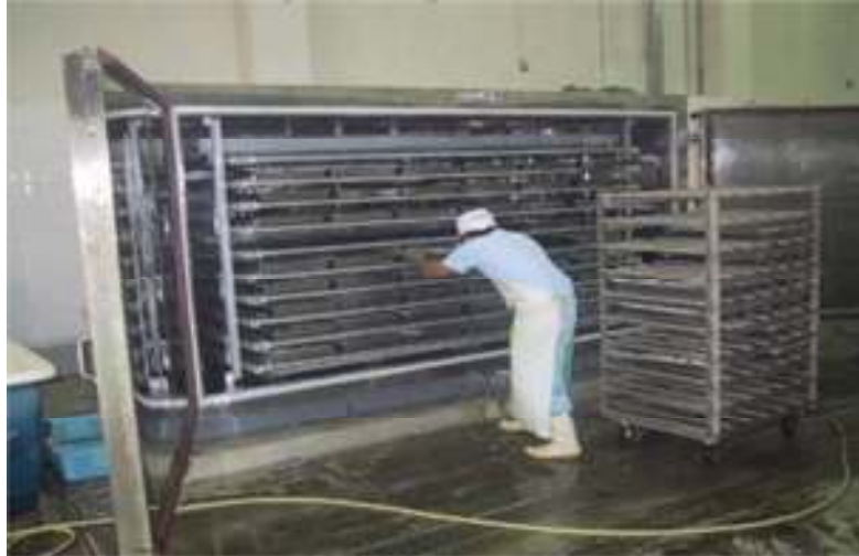
Estibado del producto en bandejas en el congelador de placas Imagen 17 Congelador de placas
