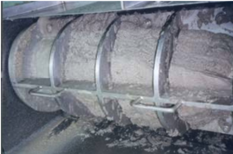
Imagen 15 Tanque de recepción
