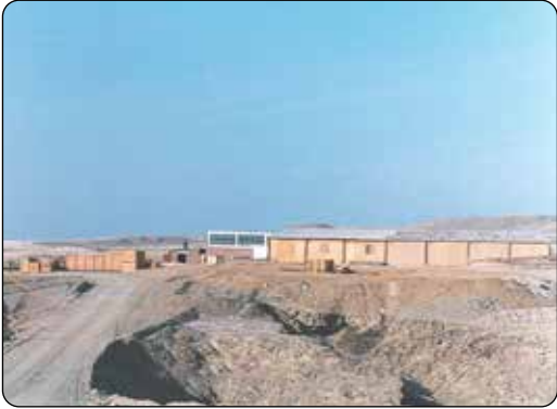
Agropesca en construcción.
