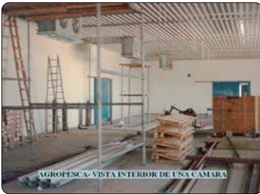
Interior en construcción de una cámara.
