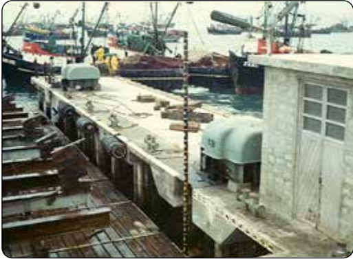
Plataforma de izaje.
