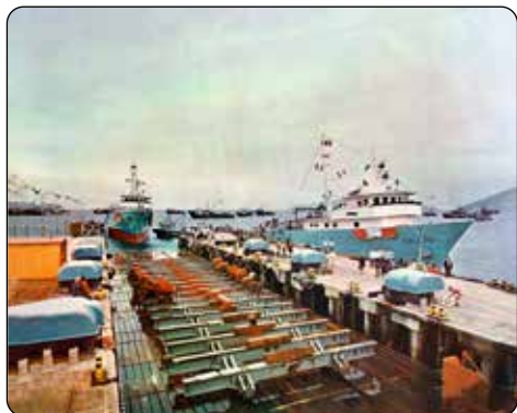
El muelle con la ampliación del sistema SYUNCROLIFT.
