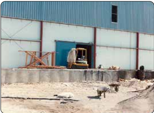
Construcción del ingreso a la planta de congelado.
