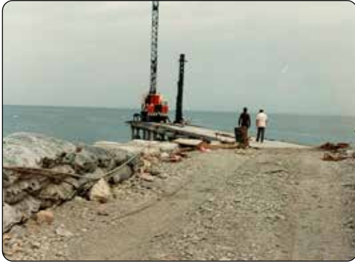
El ingreso al muelle en etapa de construcción.
